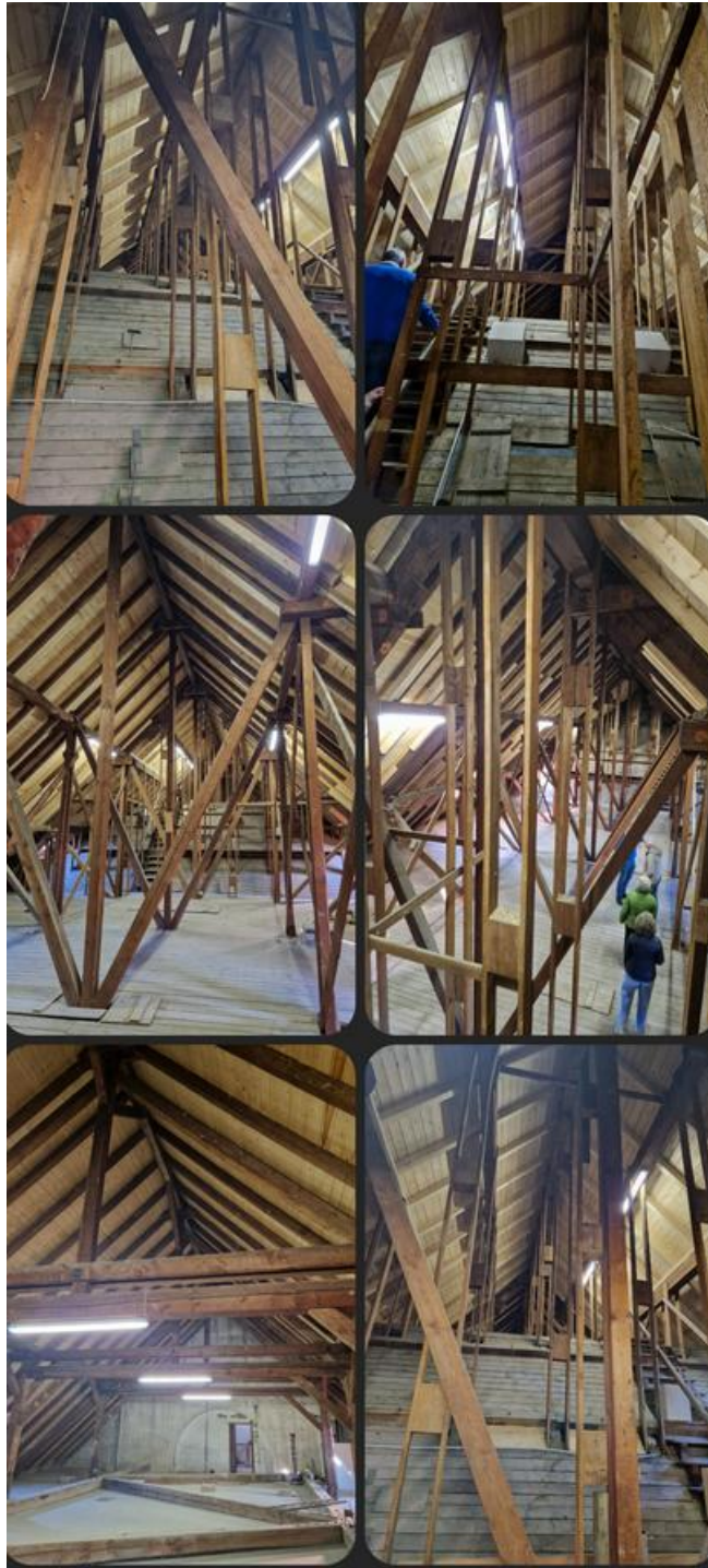
Collage 2: Eindrücke vom Dachboden.
